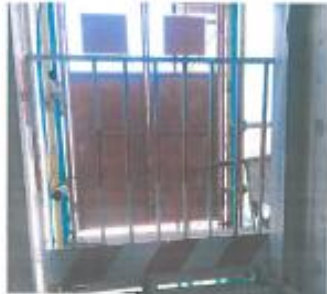
升降机接料平台。未搭设坡道的一侧已安装定型防护
