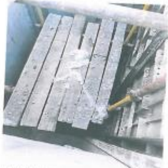
电梯井内铝模施工操作平台已满铺脚手板
