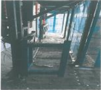
7号楼框架上铝膜材料已进行清理
