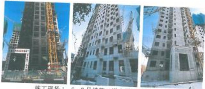
施工现场 1、6、7 号楼第二道水平网已搭设完成
