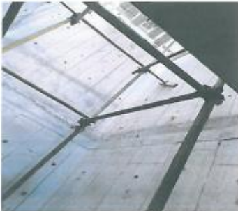
工现场电梯井内架体已进行加固
