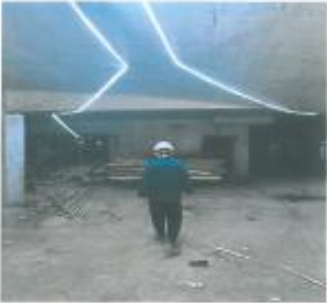
车库6区地下二层临时通道口上方模板已拆除
