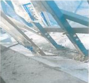
临时水管位置爬架翻板已正常放下
