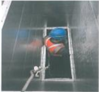
通风管道安装人员危险作业已系挂安全带
