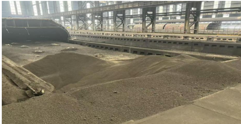
图 8 事故发生后 M9-L606 石墨化炉炉头料面情况
