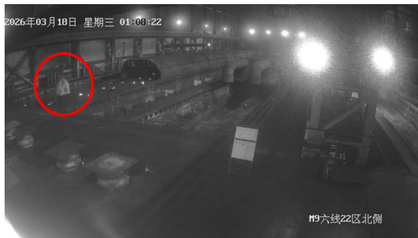
图 4 M9-L606 石墨化炉用 0-8 石墨化焦对炉头透气孔（2-1）进行封盖
