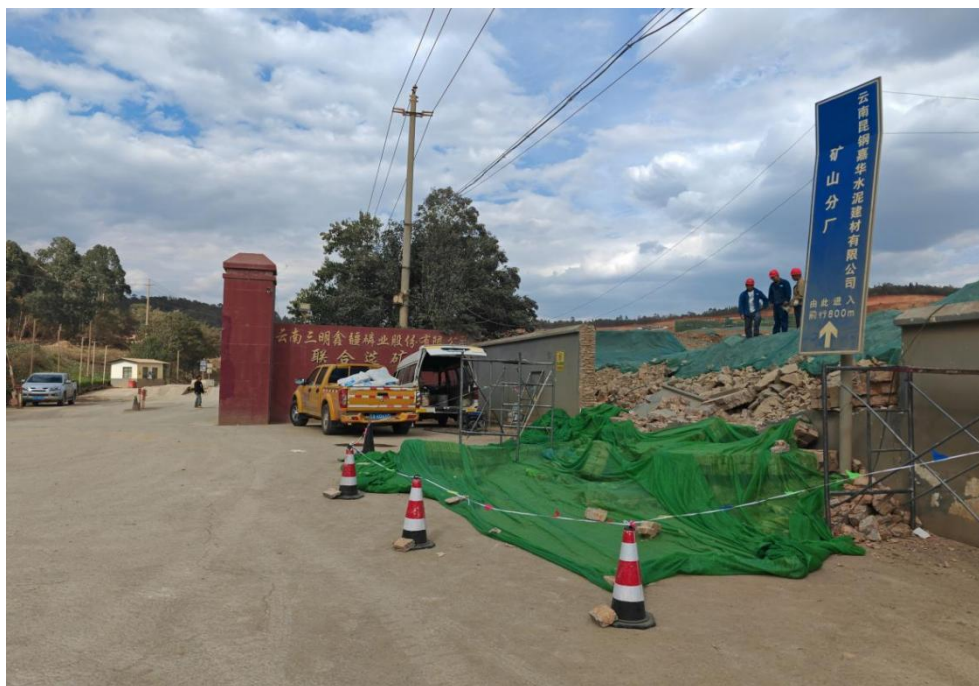
图一：现场概况图片（自西向东方向）
