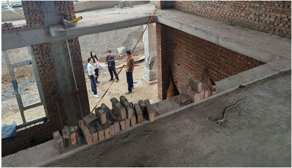
图 3 自建房二层室内走道临空面
