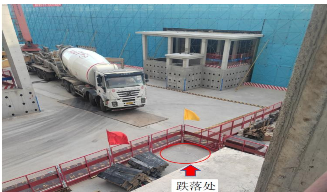
图二 落地点3#楼西南角地库顶板处
