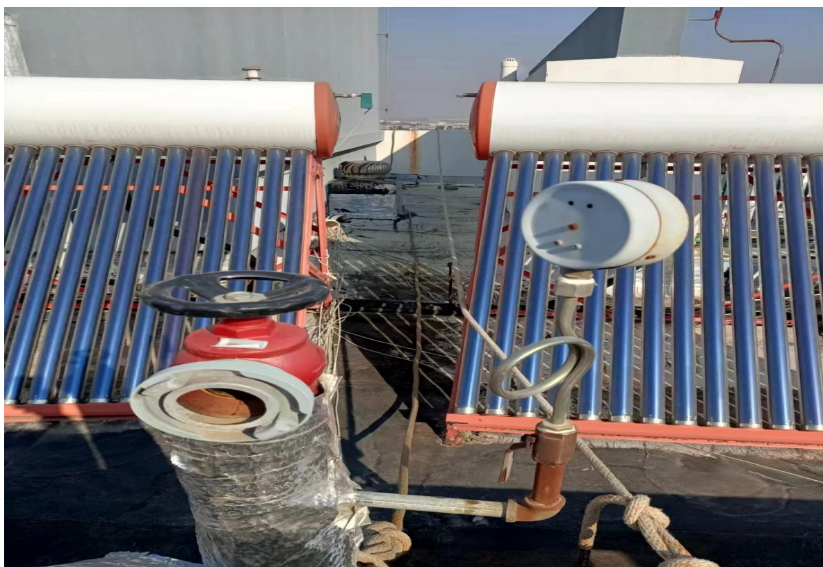
图 5：事发楼顶绳索固定情况
