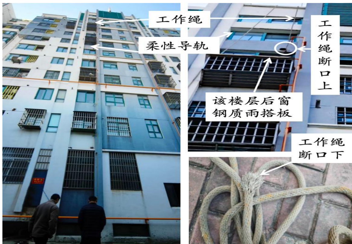
图 2：事发墙面和绳索情况
