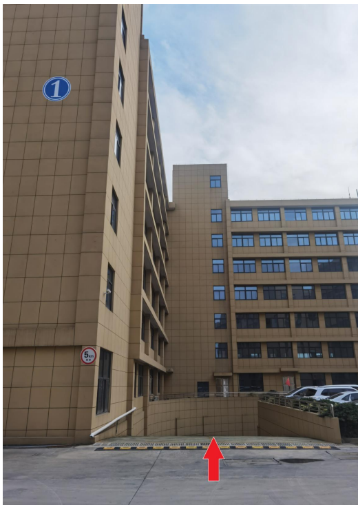
图2 事故发生单位进口处
