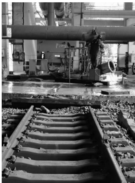
图一 1#高炉厂房高 15 道终端（由东向西拍）
