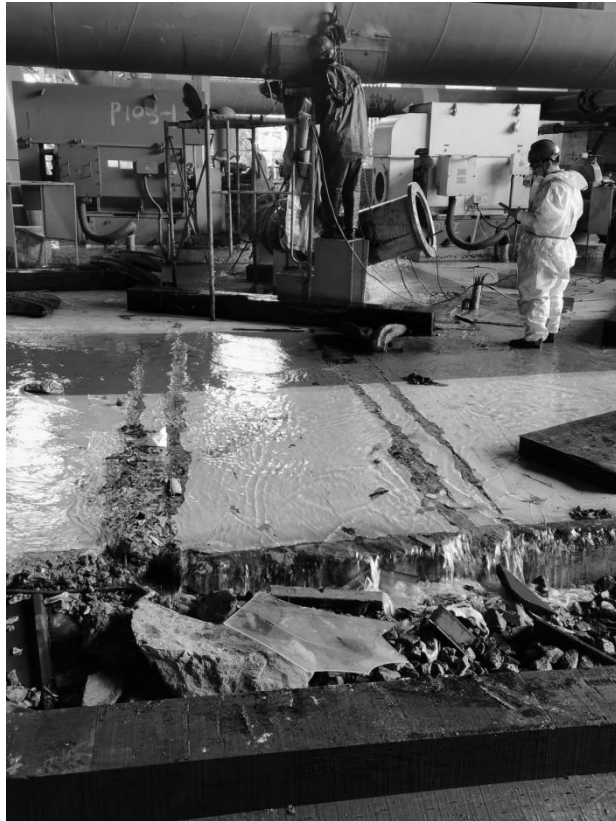
图四 环氧地坪上脱轨轨迹（由东向西拍）
