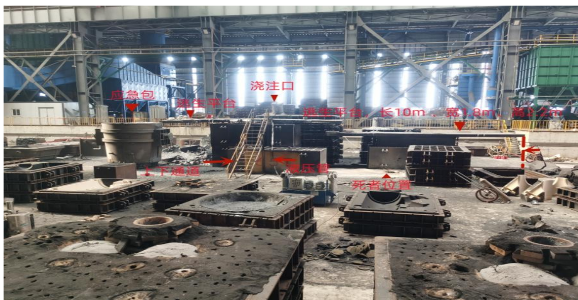
图一 浇注作业现场
