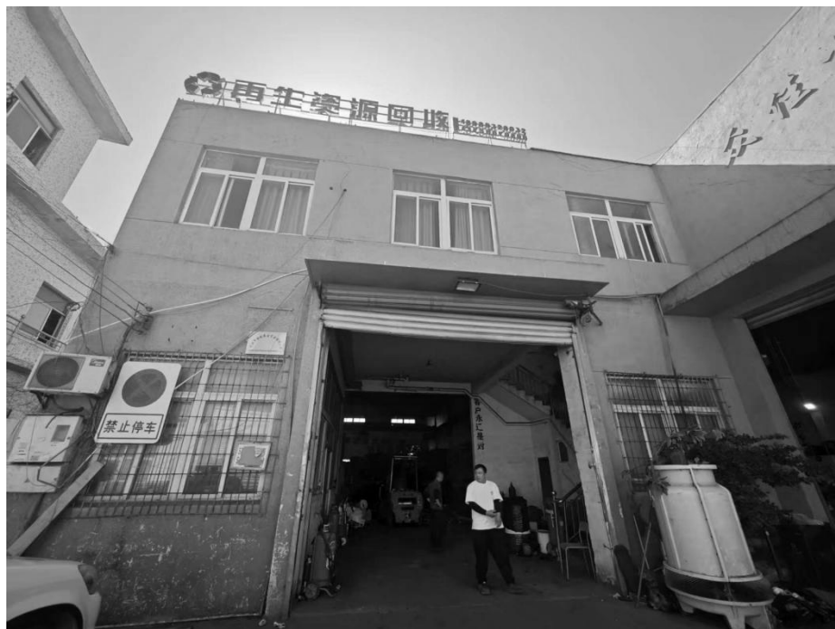
图 1 宁波市海歆再生资源有限公司正门（由东向西拍）
