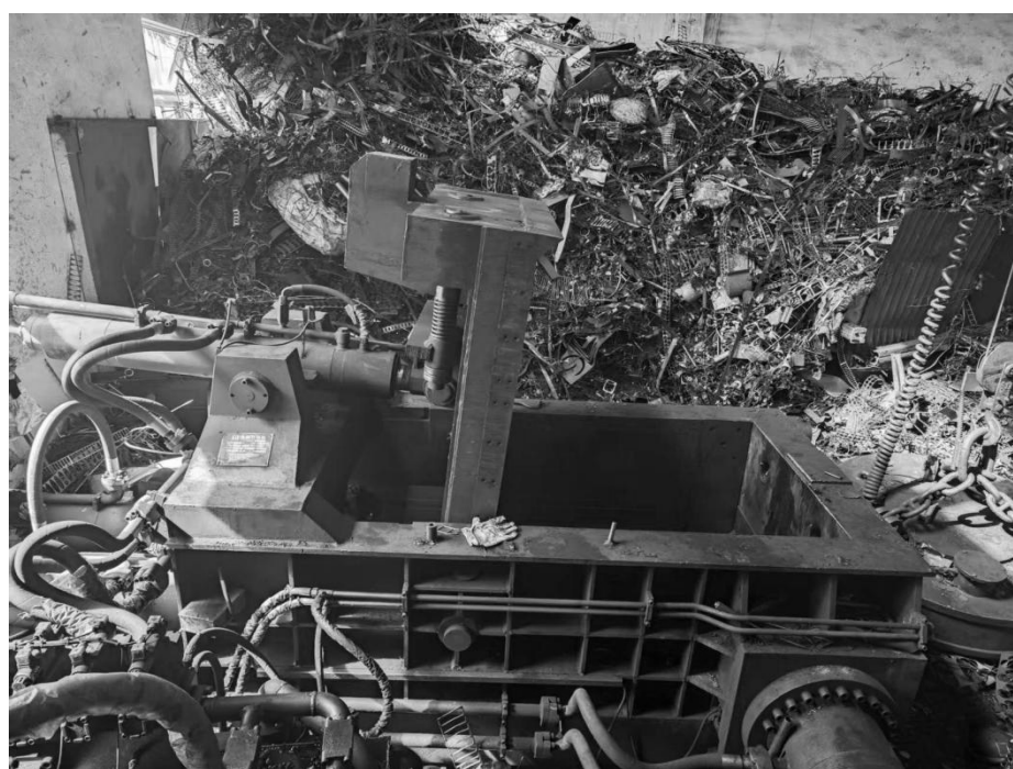
图 2 海歆公司打包车间涉事打包机（由南向北拍）
