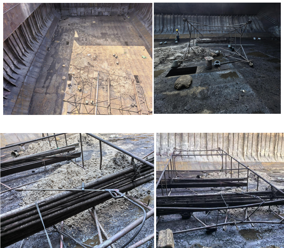
图 4 船舱内现场照片
