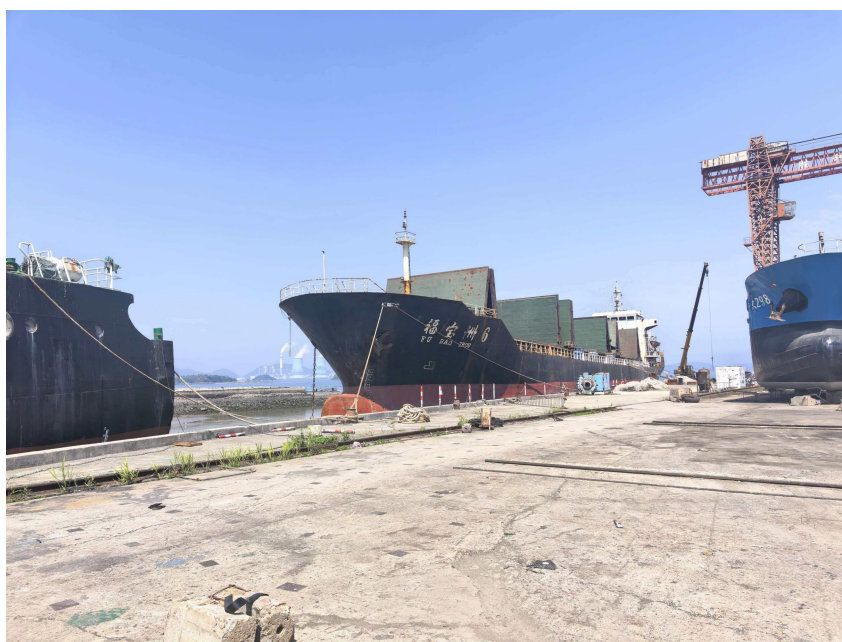
图 2 码头现场照片
