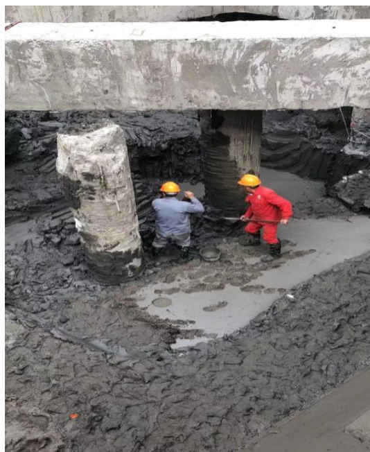
图 6 基坑放坡开挖图 1
