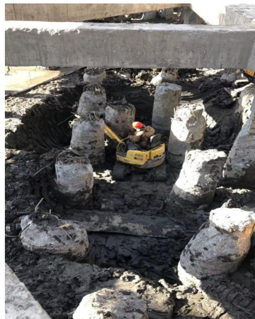
图 7 基坑放坡开挖图 2
