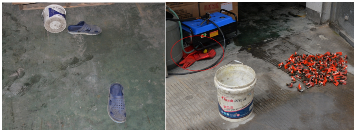
图 6 未穿戴绝缘手套和绝缘胶鞋隐患图
