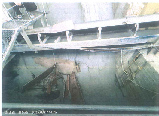
料仓 1 号库现场情况
