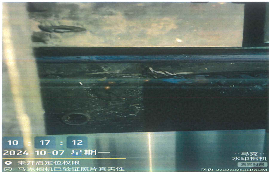
辅助辊下方沟槽
