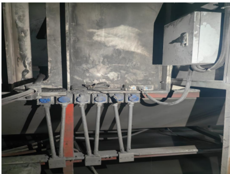
图 8：喷房的东侧面板处使用非防爆插座
