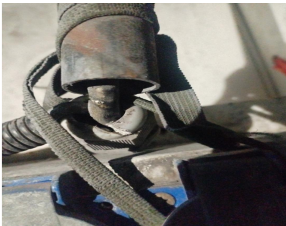
图 6：金属套管下端与插座未固定，留有间隙
