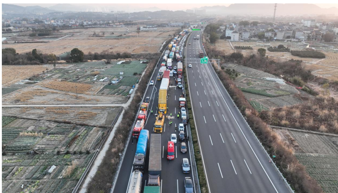
图 4 事故路段航拍图
