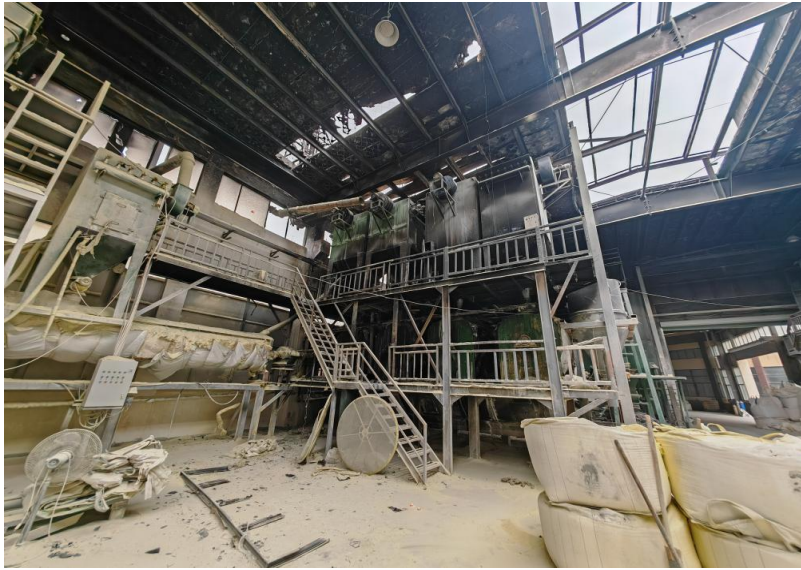
事故现场图片
