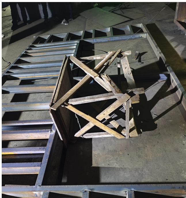
图 2 倾倒的木凳，木凳支撑支架木料断裂
