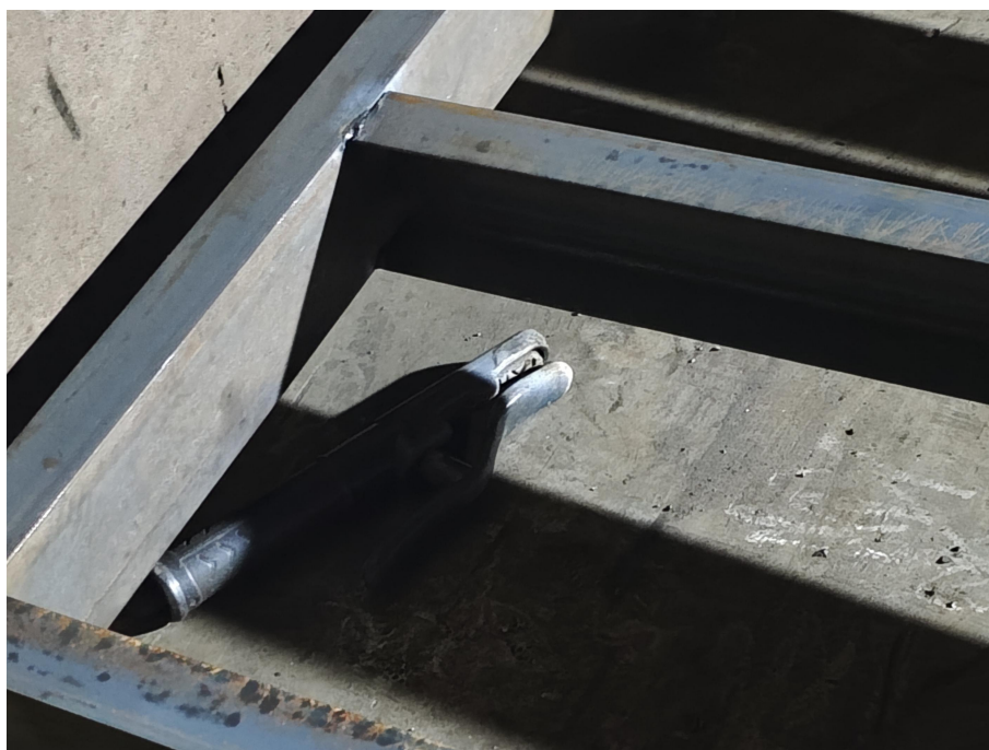
图 3 油箱底座下方压有电焊钳
