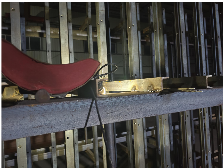
图 4 框架上放置有电焊面罩、焊条、照明灯等工具
