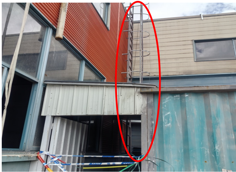
图 3 厂房外墙竖向爬梯
