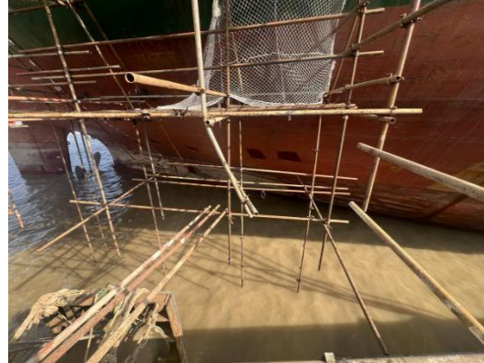
（图二 船艏侧第一跨作业平台及人员上下通道）
