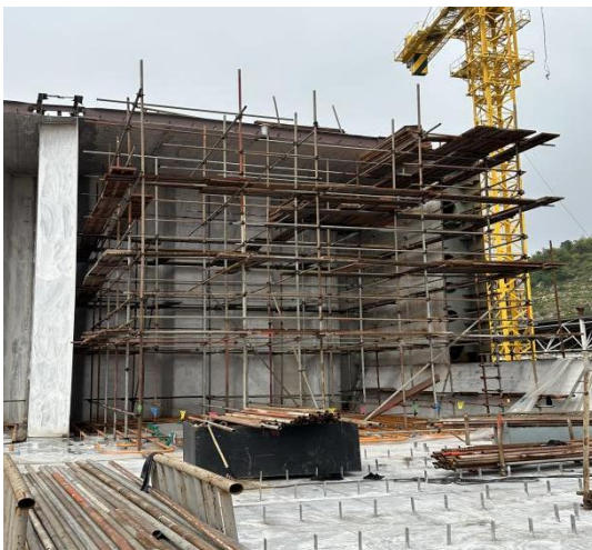
（图三 五号货舱右侧脚手架总体结构搭设为四层五空）
