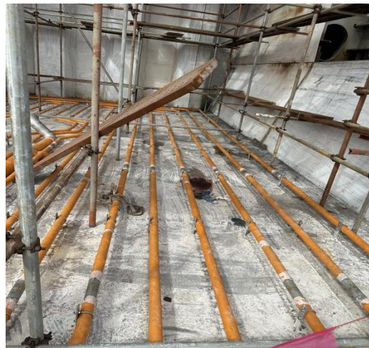
（图三 五号货舱右侧脚手架总体结构搭设为四层五空）
