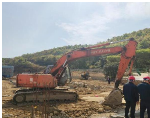
（图四 挖掘机大臂侧向西南方向，小臂与大臂呈 90°弯曲）
