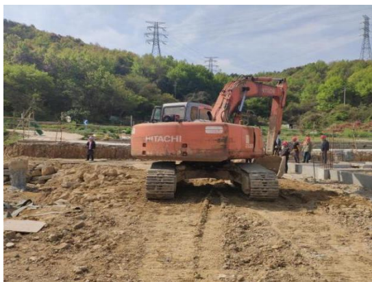
（图三 路面上挖掘机朝北行驶的痕迹）
