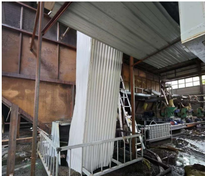
图 2-3 成品冷却仓底部现场图
