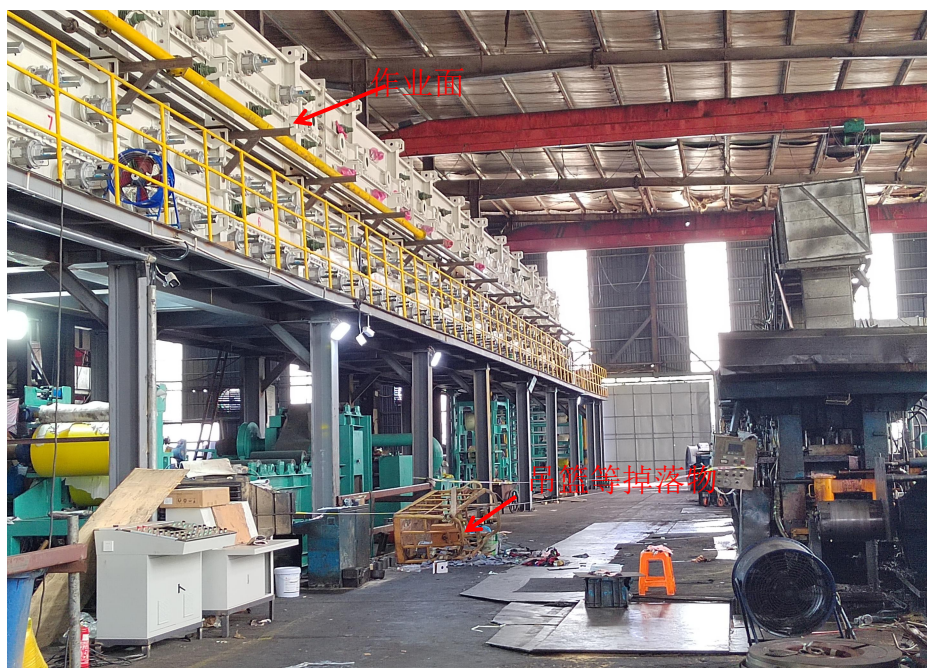
图二 事故发生现场图
