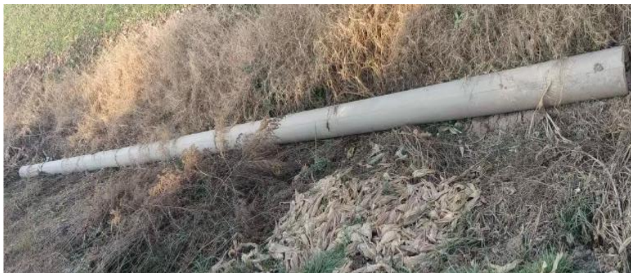
图 2 事故电杆图片
