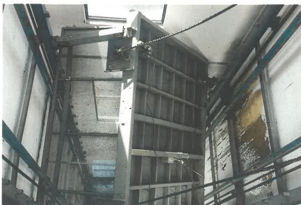
图 2-3 翻转倒扣的工作平台
