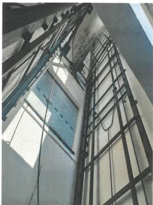
图 2-1 井道钢结构（仰视）
