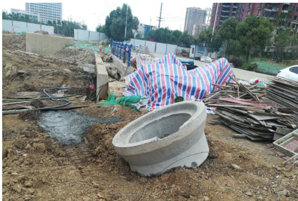
图 1 被切割涵管的承插端
