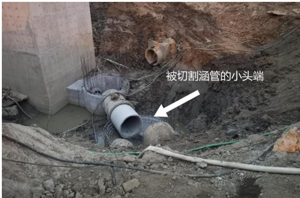
图 3 现场核查时被切割涵管一端已安装在转接井
