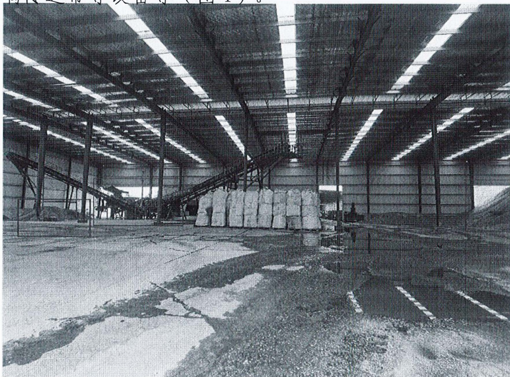
图 1 洗玻璃车间(从左到右分别为东北方玻璃渣堆、玻璃渣处理设备、东南方玻璃渣堆)
