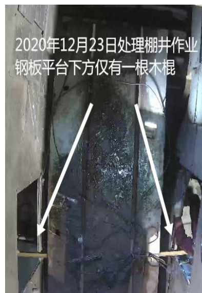
图8 2020年12月23日 处理棚井作业现场图
