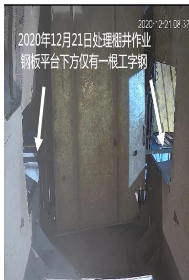
图7 2020年12月21日 处理棚井作业现场图
