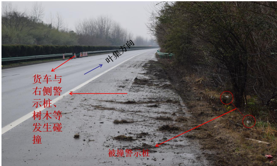
图 2 货车行驶右偏移刮碰处
