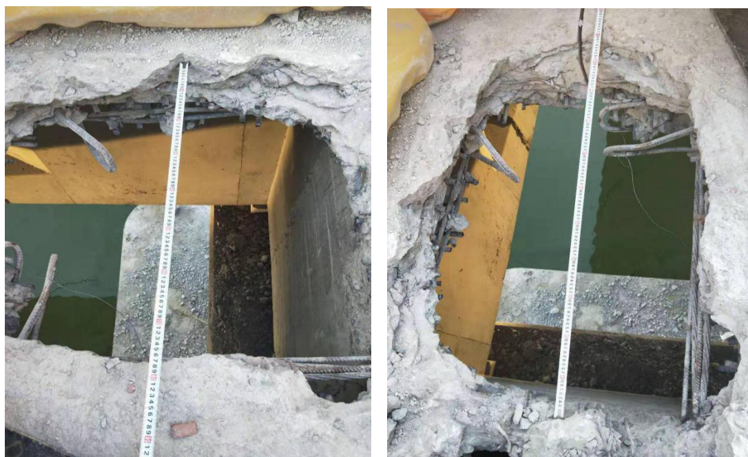
图 1 梁端孔洞平面尺寸 90×75cm
