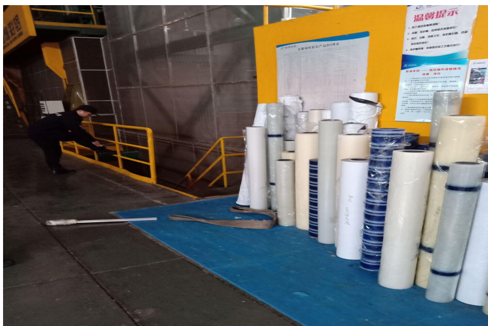
图2 事故区域的地坑入口
