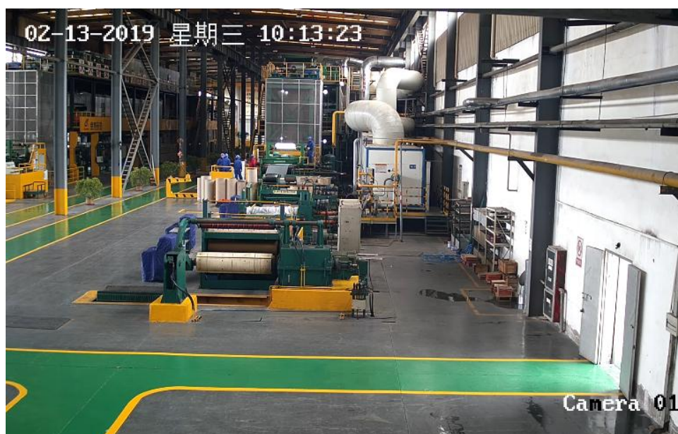
图 1 彩涂车间 1 号摄像头监控视频显示的事故区域
