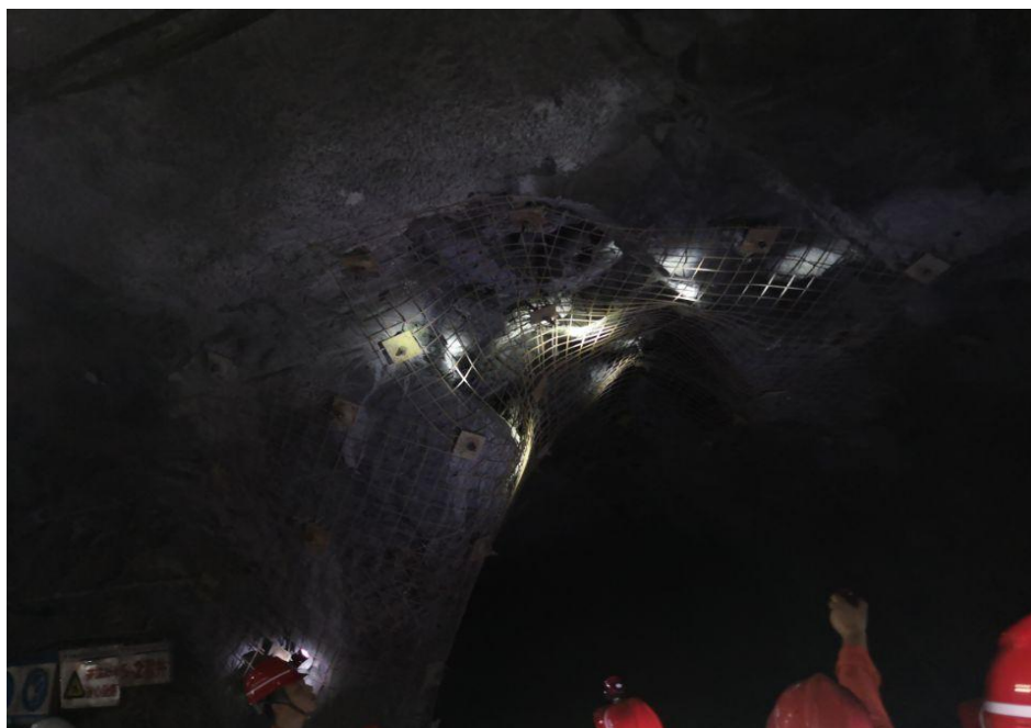
图3 事故地点附近穿插的破碎带
