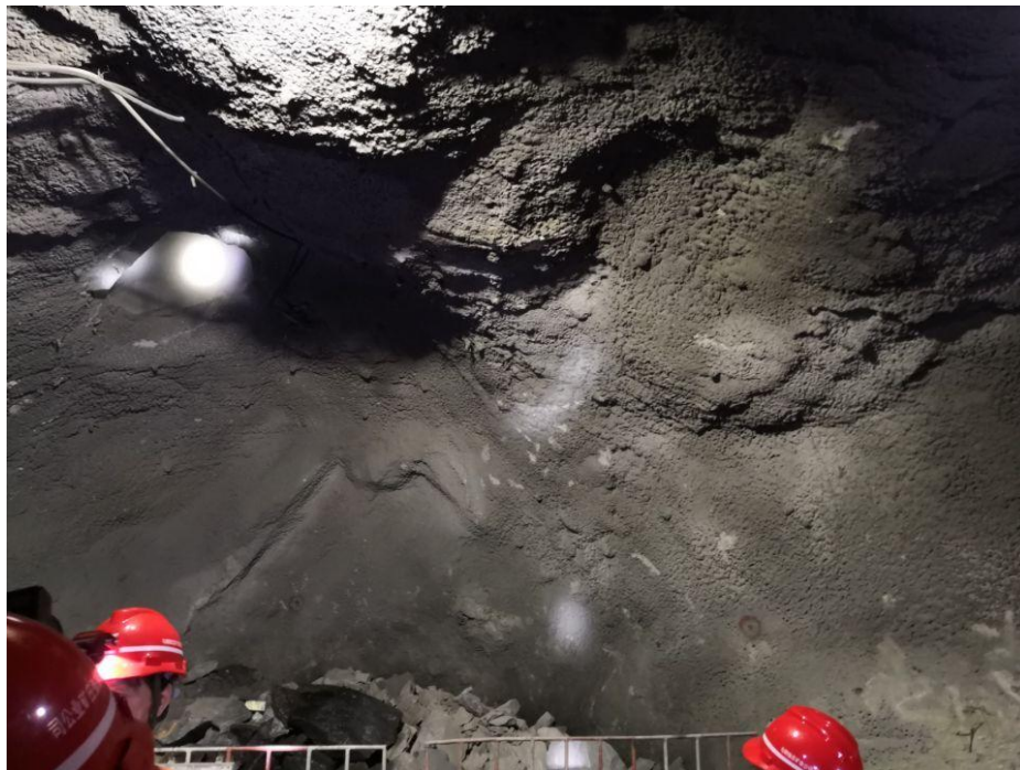
图 2 顶板冒落后进行的锚网喷支护
