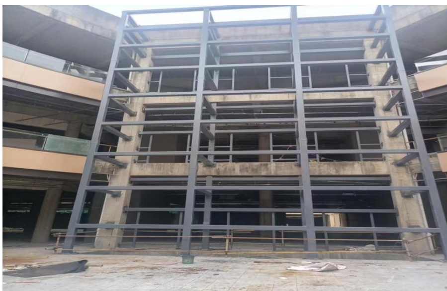
图 2 电梯井道钢结构现场图
