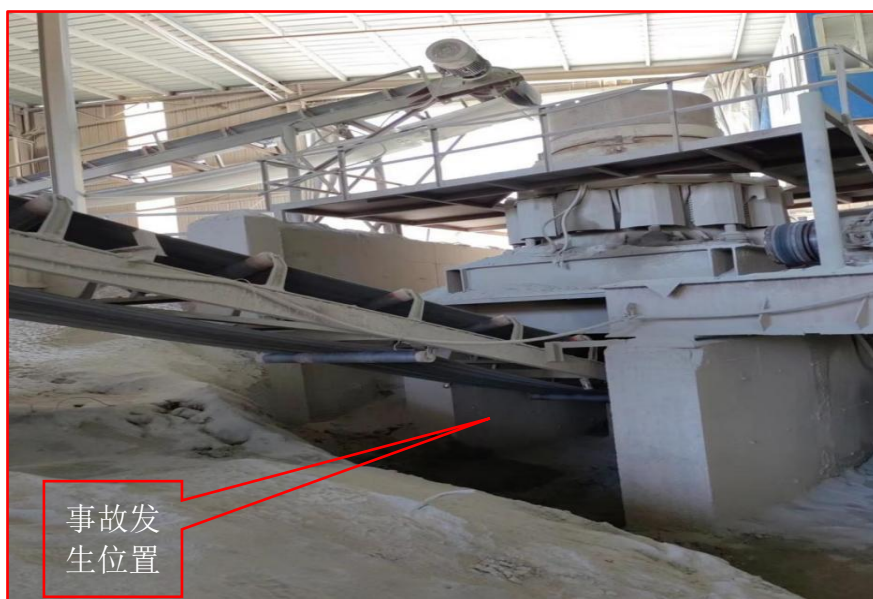
图2 事故发生位置
