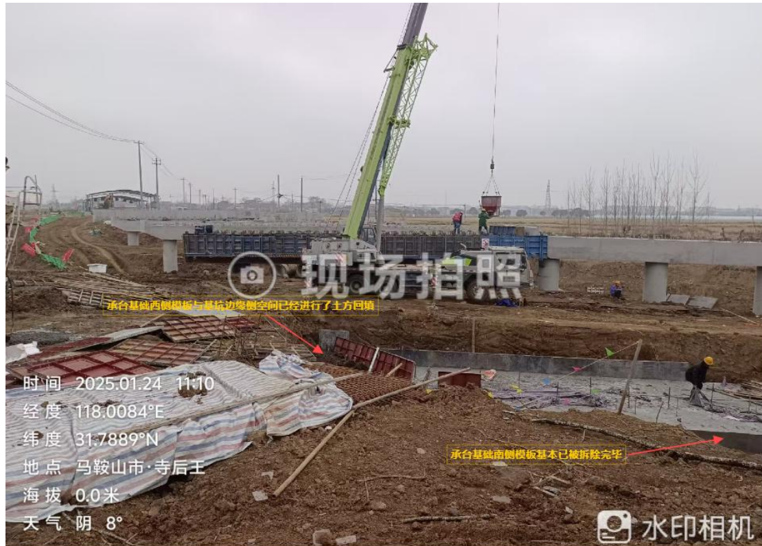
图 2 土方回填后的现场
