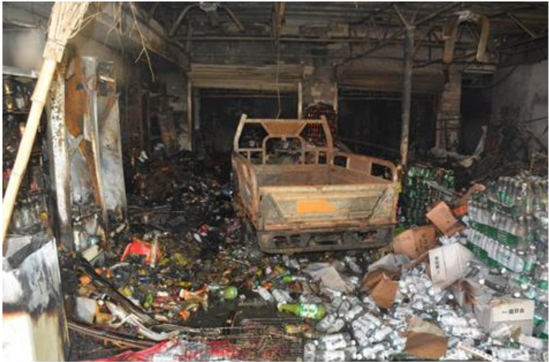
图 6 事故建筑一层前厅西侧过火情况
