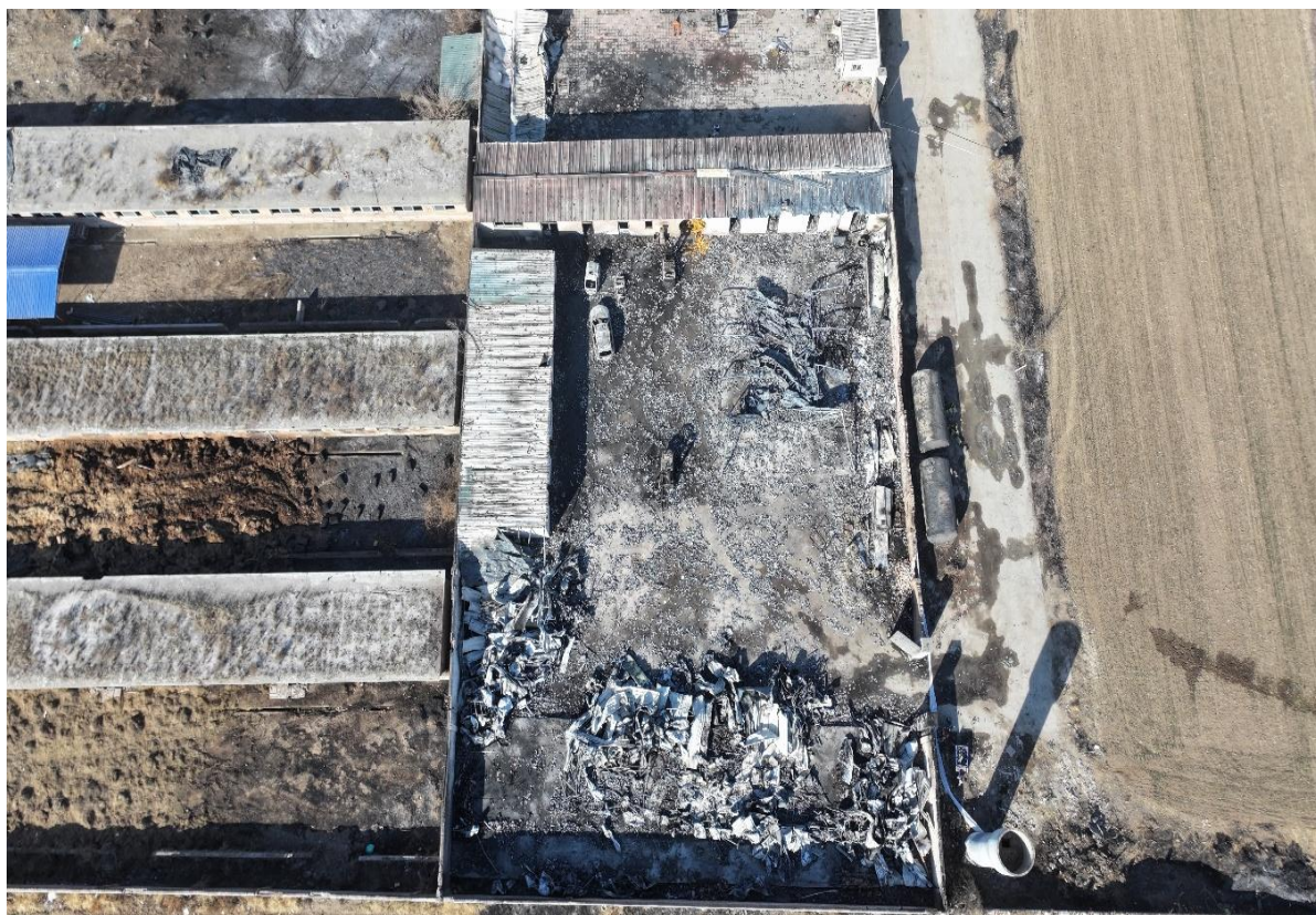
图3 事故发生后的航拍图
