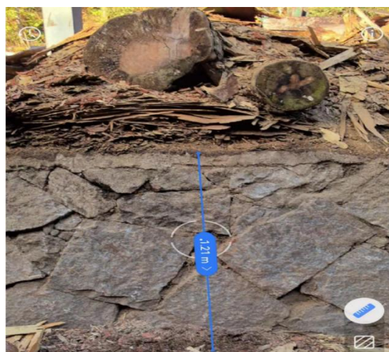
照片 4：装载机翻车处临边高度
