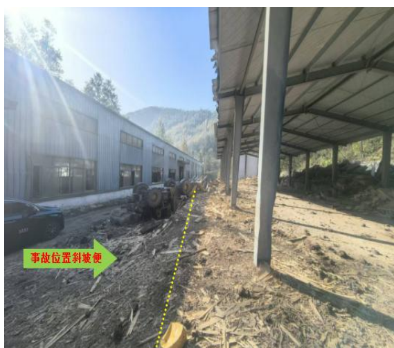
照片 3：事故位置运输便道
