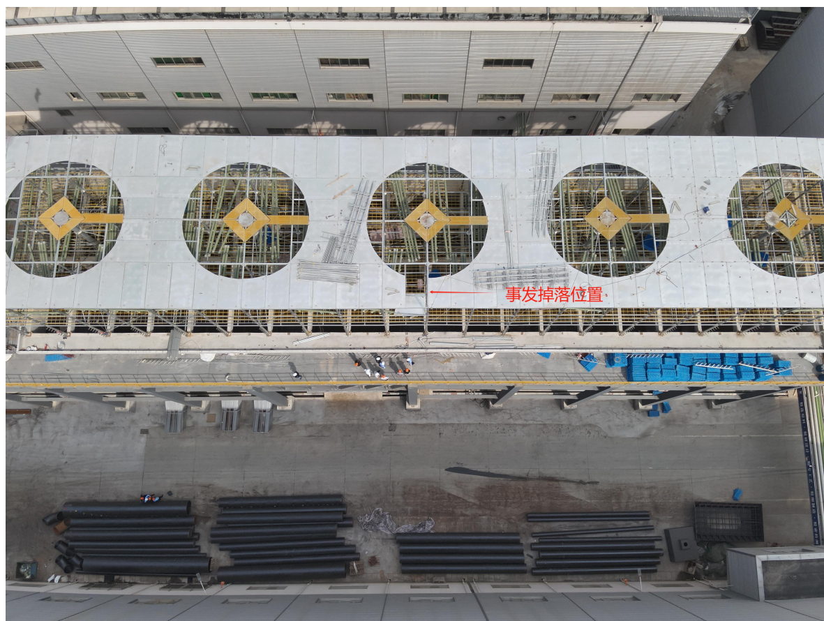
图 2 事发维修中心顶楼
