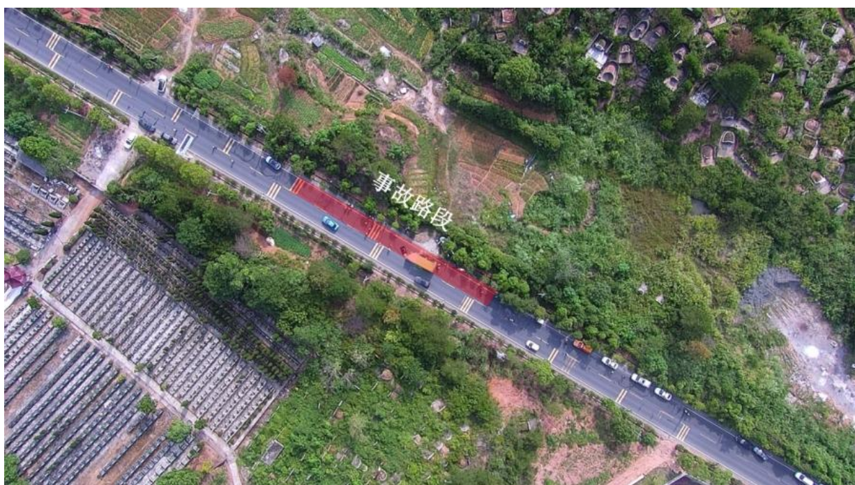
图 4 事故现场道路
