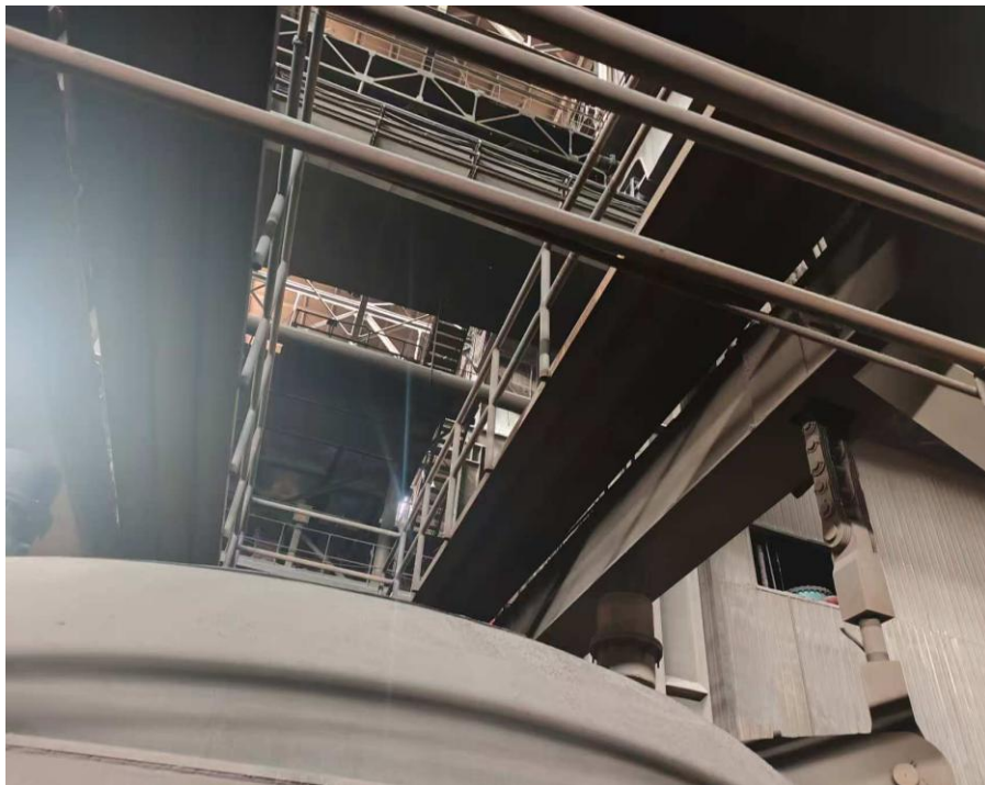
图四 检维修作业平台
