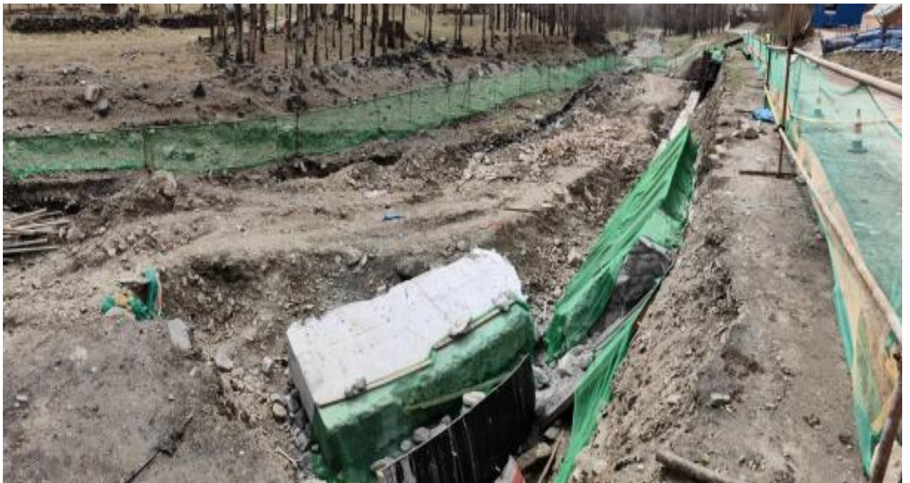
图 1 现场照片（远处未拆模的是第 1 段，近处倒塌的是第 5 段）
