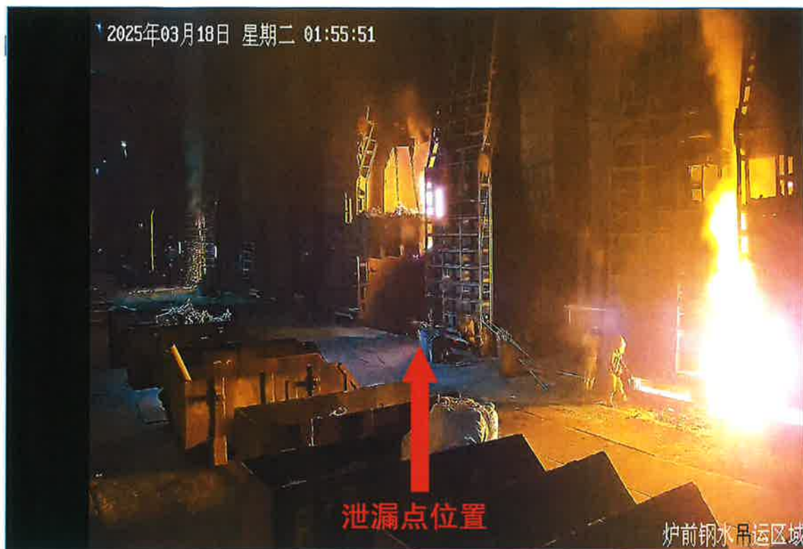
图 1 行车已在炉口装废钢--底部托圈泄漏点位置
