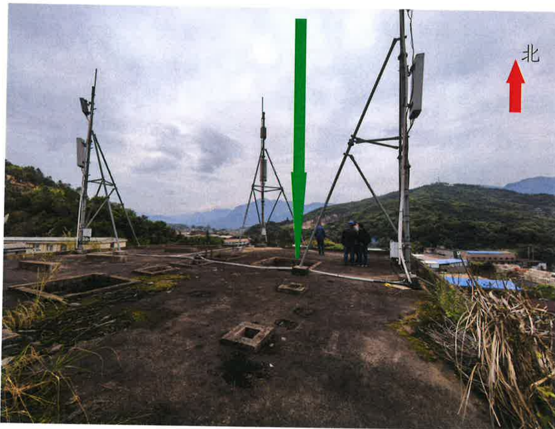
图 1 事发作业点（绿色箭头所示为落点，楼面可见孔洞若干）
