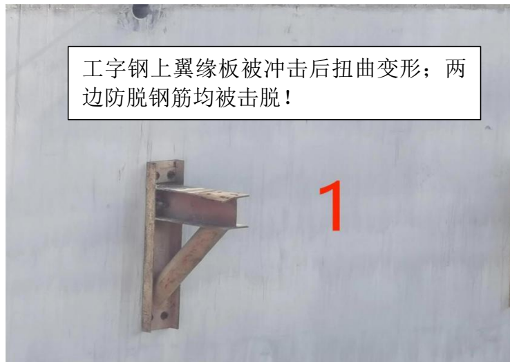
图 7 事发筒仓 1#钢牛腿图片
