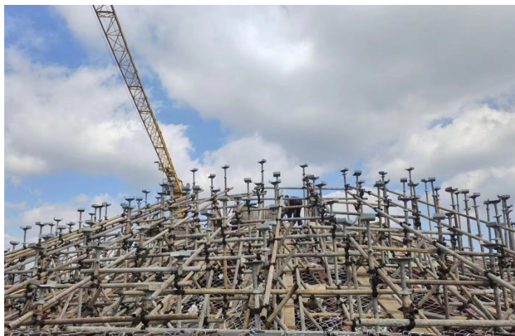
图3 仓顶支撑架体搭设实景图（示意图，非事发筒仓）
