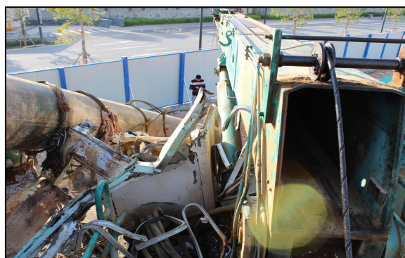
图 3：静力压桩机大臂状态
