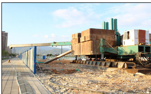
图 2：静力压桩机停放的位置
