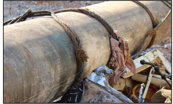
图1:送桩器上钢丝绳绑扎情况
