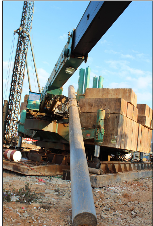
图 7：送桩器和吊机驾驶室位置关系
