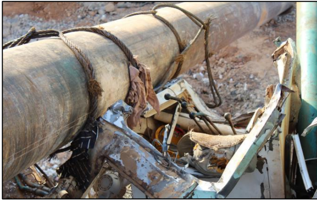
图 6：变形的吊机驾驶室
