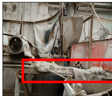
图 1 第一现场 检修平台
