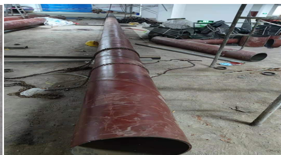
图 5：吊装的螺旋焊接钢管
